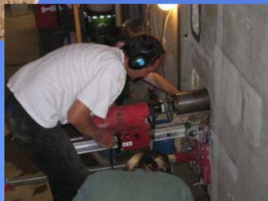
Im Lysimeterkeller werden Rohre zur Kabelführung verlegt.
